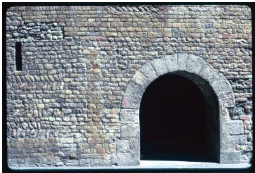
Payerne. Dettaglio di un muro con arco
