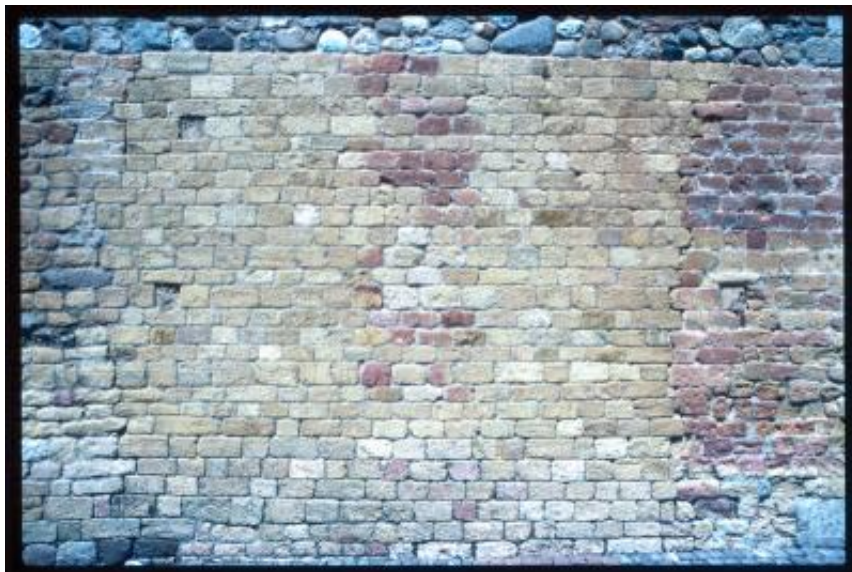
Payerne. Dettaglio di una muro
