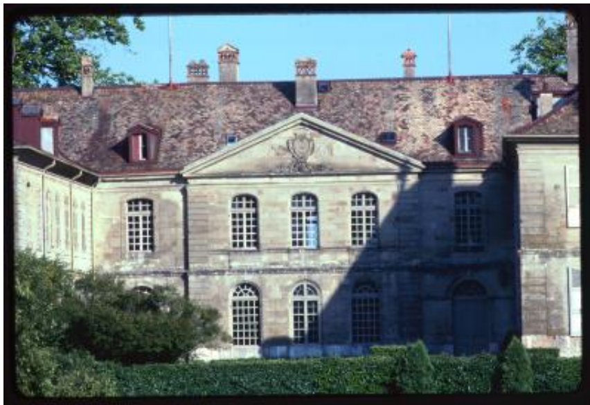
Prangins. Dettaglio della facciata del castello
