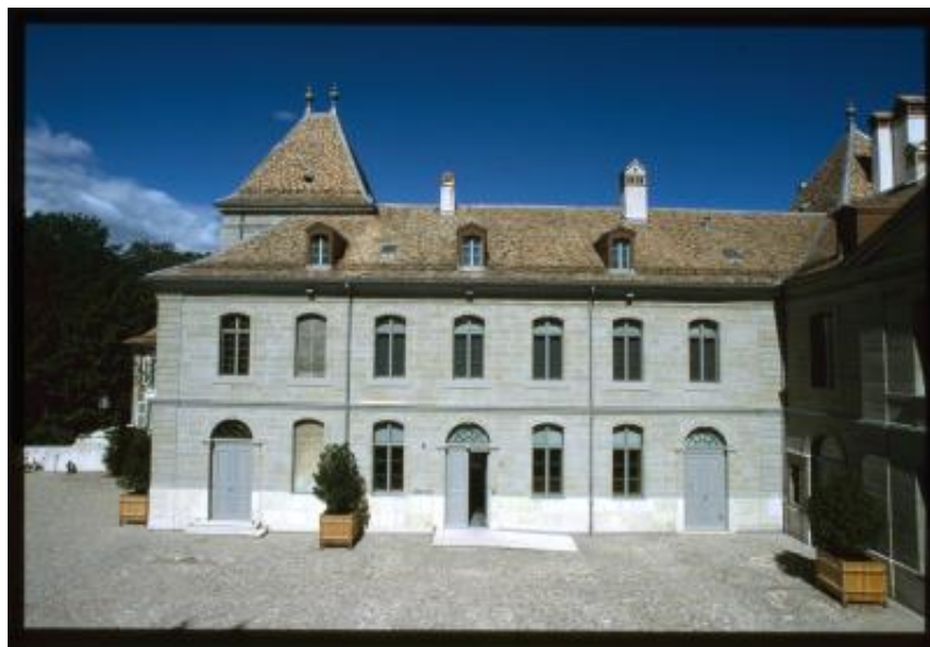
Prangins. Facciata sud del castello
