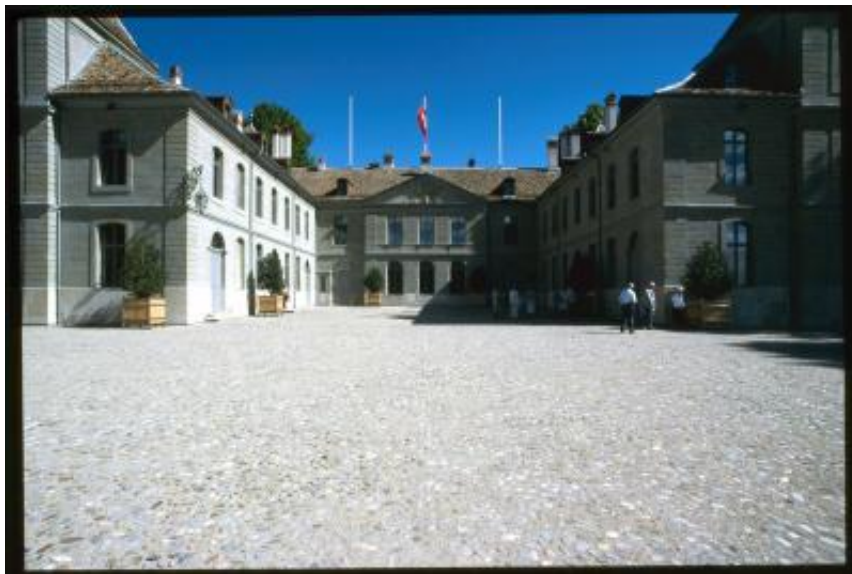
Prangins. Facciata principale del castello
