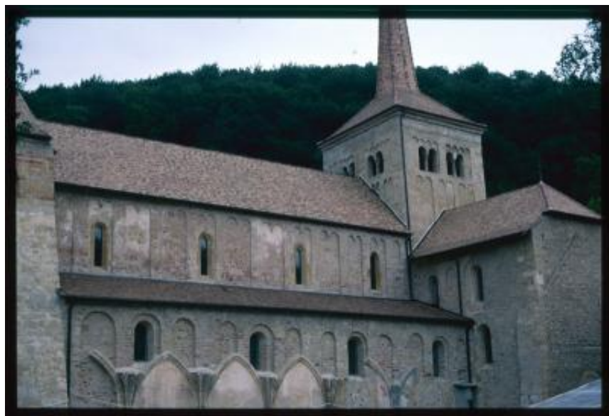
Romainmôtier-Envy. Fiancata della chiesa abbaziale
