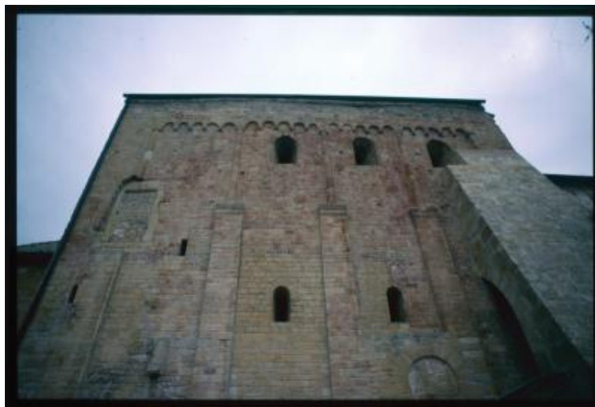
Romainmôtier-Envy. Dettaglio di un muro del complesso abbaziale
