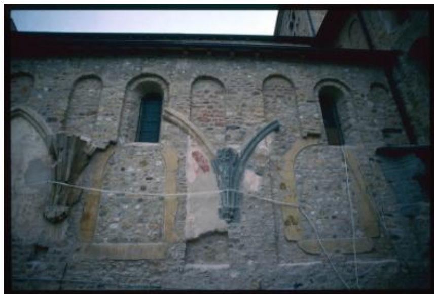
Romainmôtier-Envy. Fiancata della chiesa abbaziale con resti della precedente struttura
