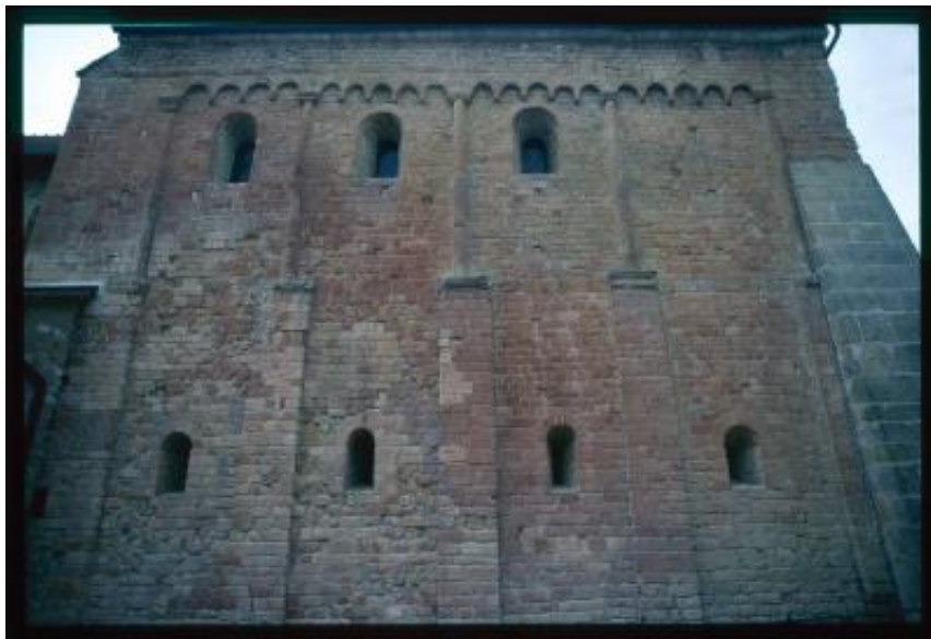
Romainmôtier-Envy. Dettaglio di un muro dell'Abbazia
