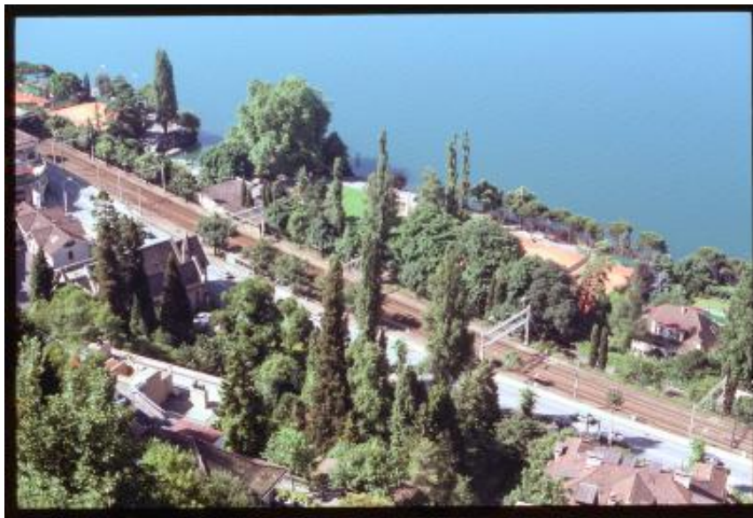
Montreux. Veduta dall'alto della linea ferroviaria della frazione di Territet
