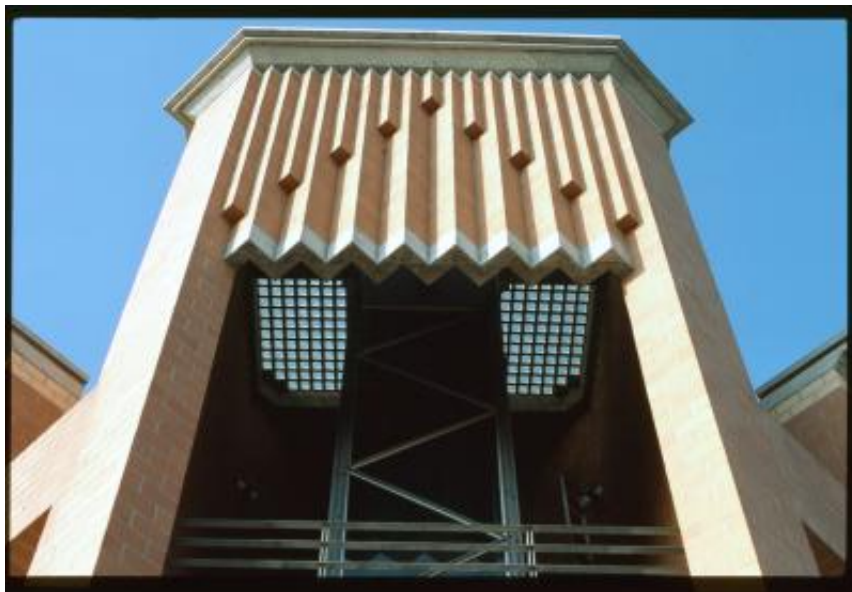
Uster. Dettaglio di un edificio appartenente al complesso commerciale Berani
