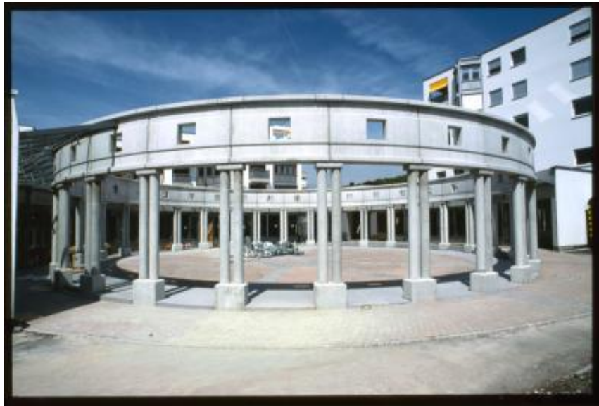
Uster. Piazza circolare delimitata da un colonnato del Tertianum AG Brunnehof
