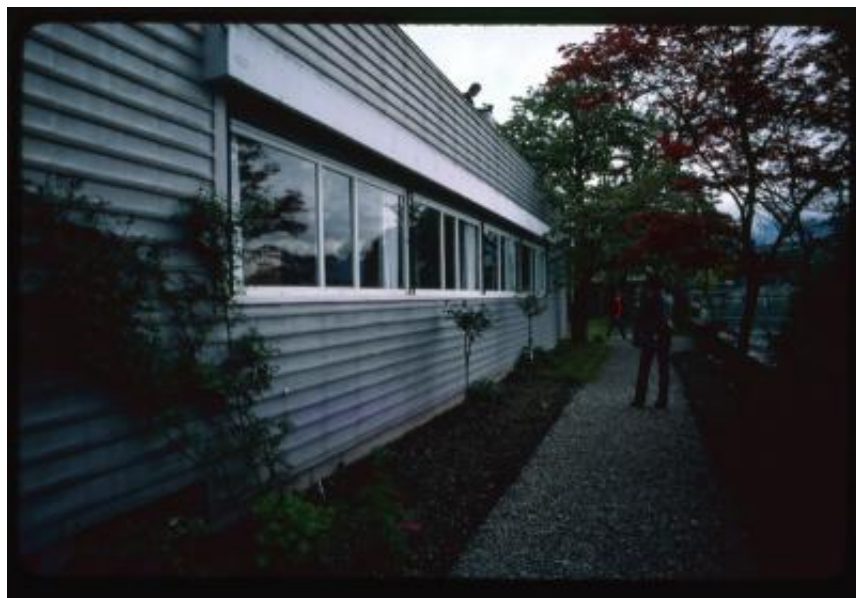
Vevey. Facciata della Une Petite Maison vista lateralmente
