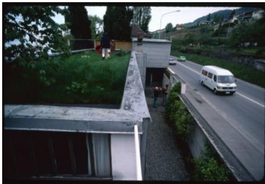
Vevey. Veduta del tetto della Une Petite Maison
