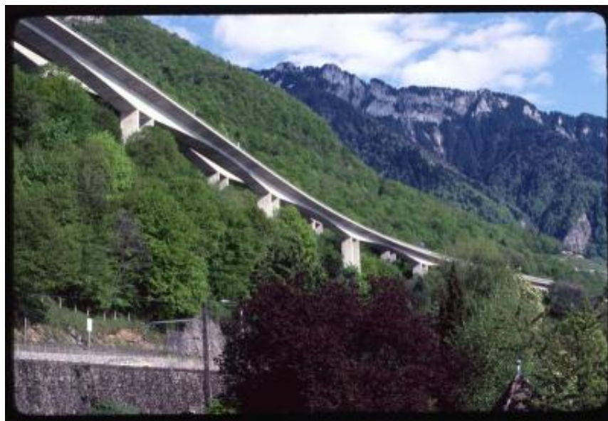
Veytaux. Veduta del viadotto di Chillon
