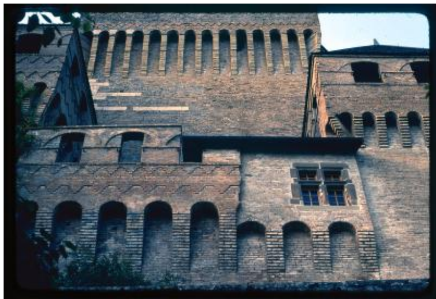
Vufflens-le-Château. Dettaglio dei muri e del torrione del castello
