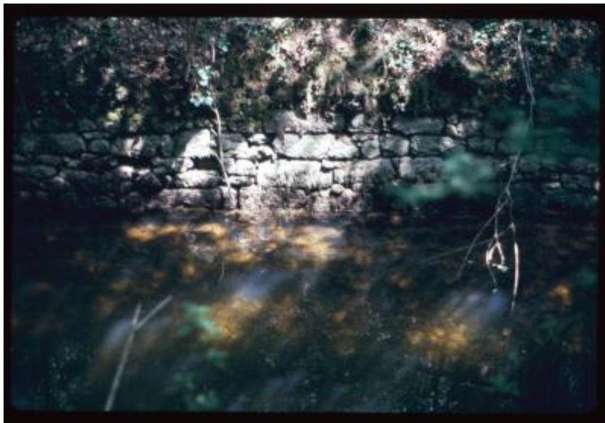
Canal d'Entreroches. Dettaglio di un muro
