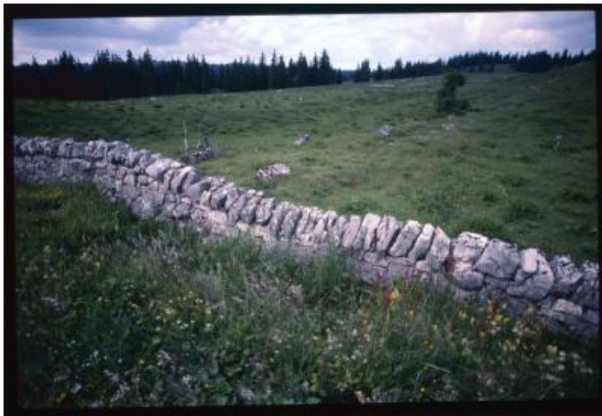
Col du Marchairuz. Dettaglio di un muro a secco
