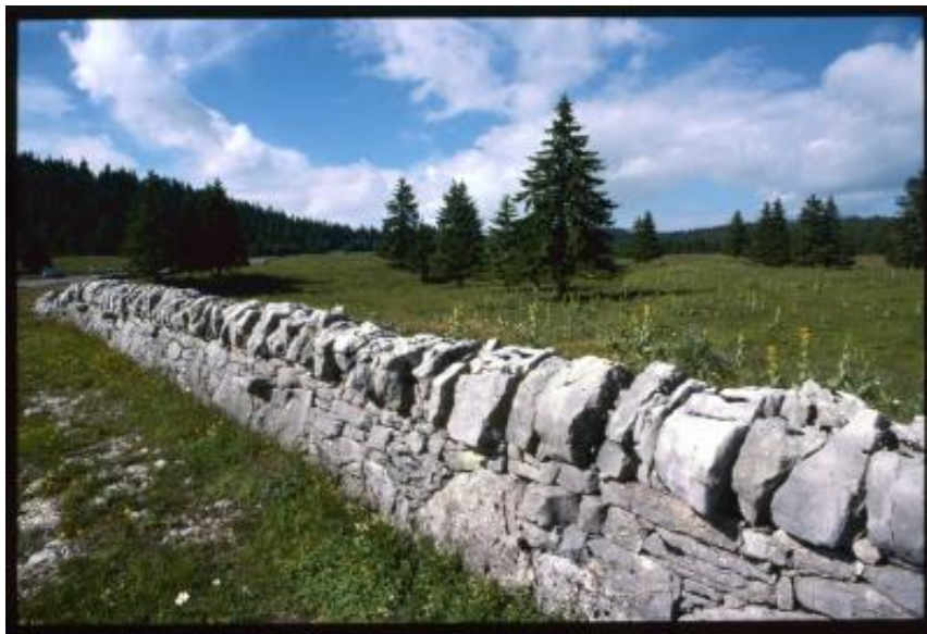
Col du Marchairuz. Dettaglio di un muro a secco
