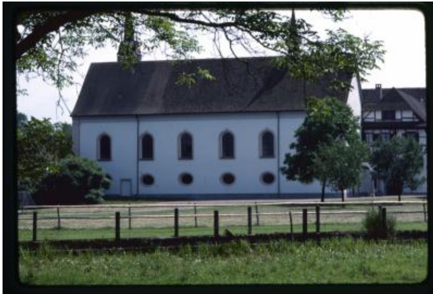
Cham. Veduta laterale della chiesa dell'Abbazia di Frauenthal
