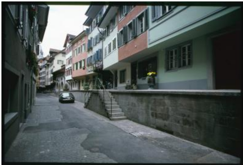
Zugo. Veduta di una strada del centro storico
