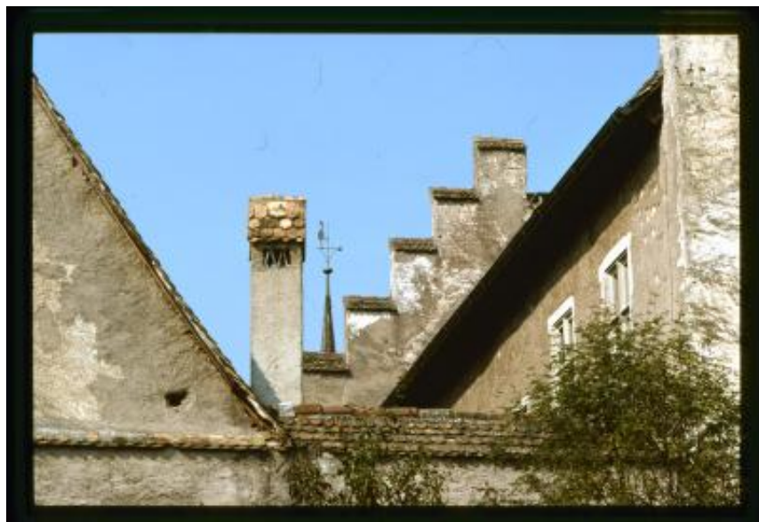
Bubikon. Dettaglio di un camino della Ritterhaus
