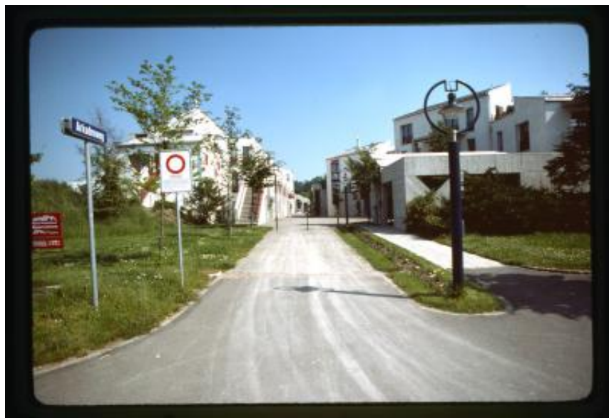
Dübendorf. Veduta di un gruppo di edifici nel Siedlung Chriesmatt
