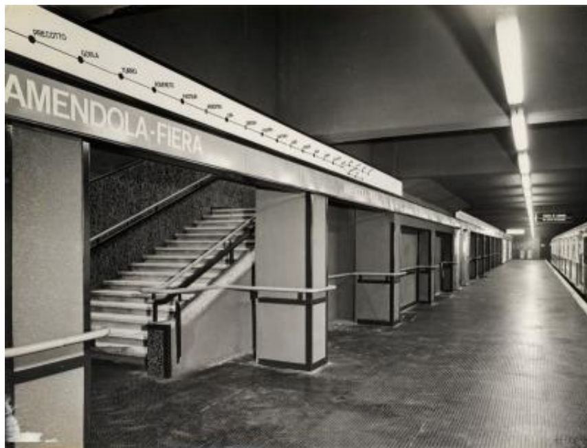
Banchina della stazione Amendola Fiera a Milano a lavori ultimati
