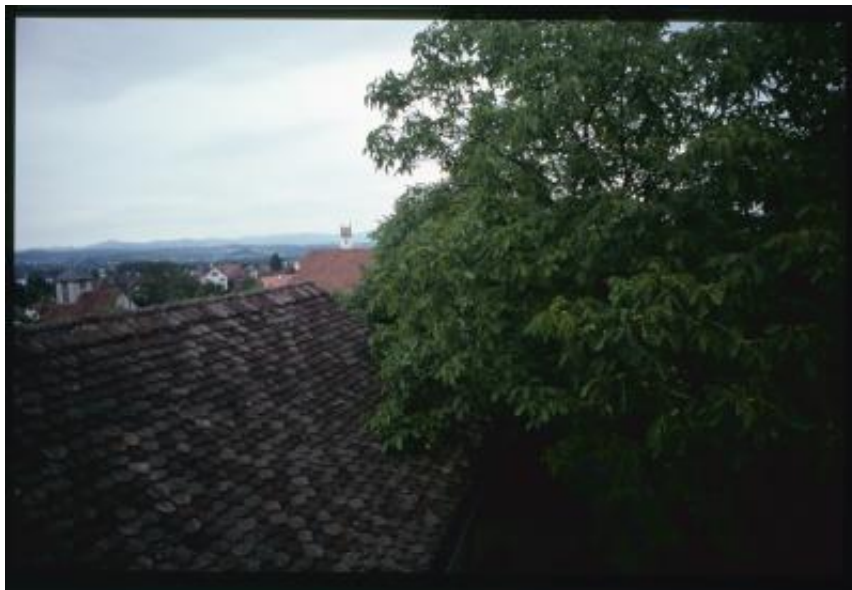
Maur. Scorcio del tetto di un edificio
