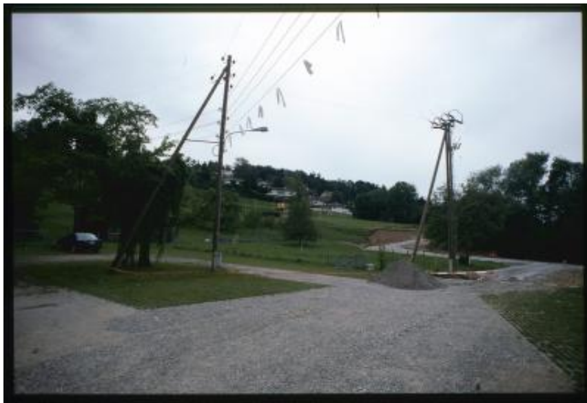
Maur. Lavori stradali in un parco
