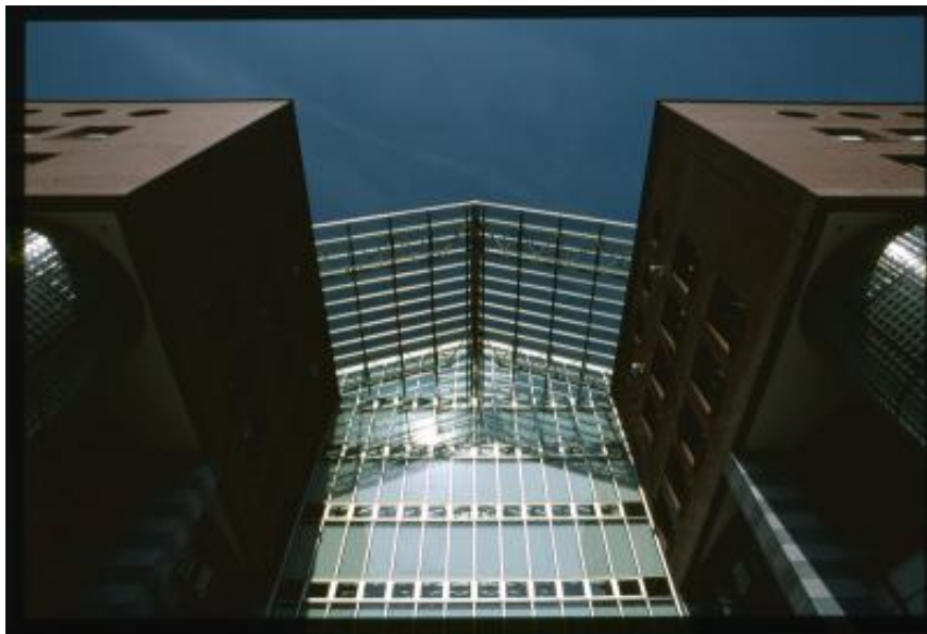
Opfikon. Parte superiore della facciata principale della Galleria
