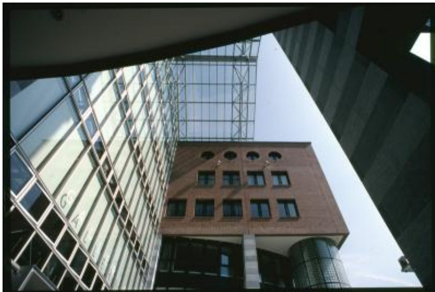
Opfikon. Dettaglio della facciata principale della Galleria
