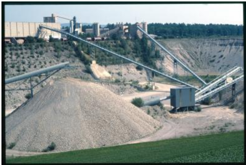
Weiach. Veduta di una cava di ghiaia
