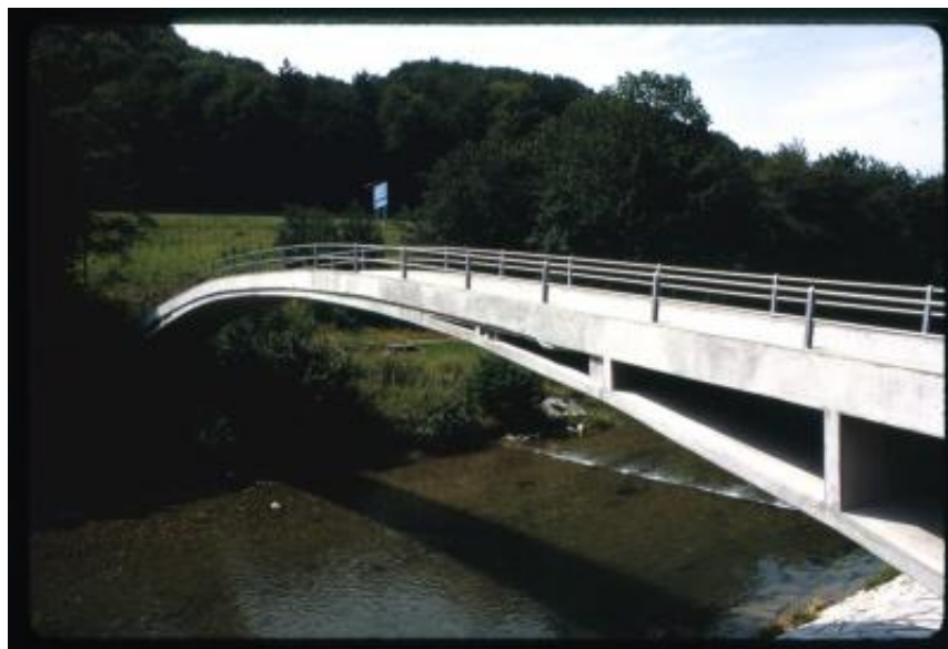
Winterthur. Passerella sul fiume Töss di Robert Maillart nel distretto di Wülflingen
