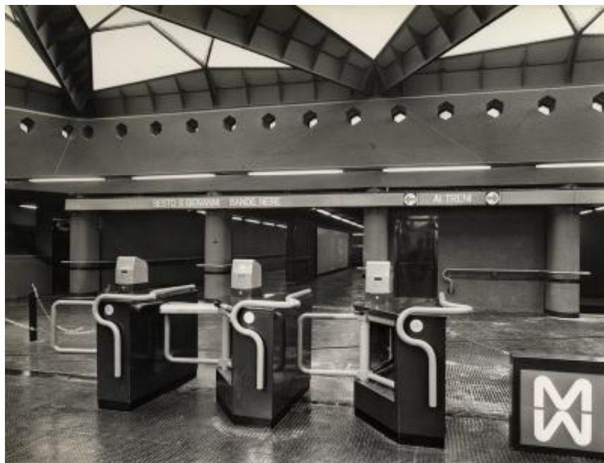
Interno del mezzanino della stazione Amendola Fiera a Milano a lavori ultimati
