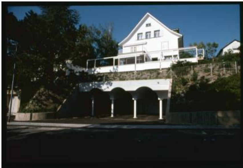
Zollikon. Veduta di un'abitazione sulla Goldhaldenstrasse
