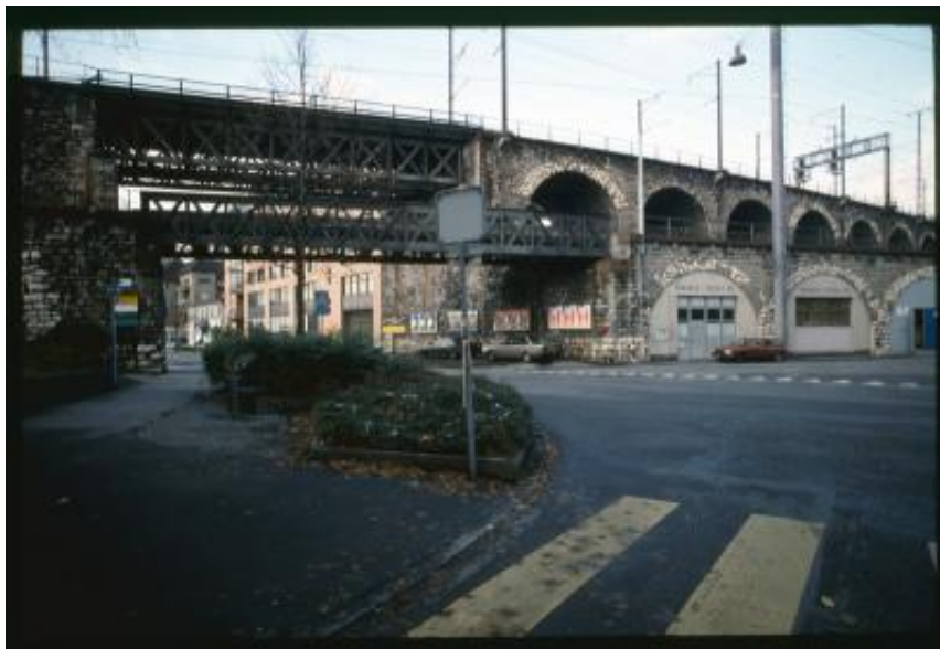
Zurigo. Ponte ferroviario nel distretto di Aussershil
