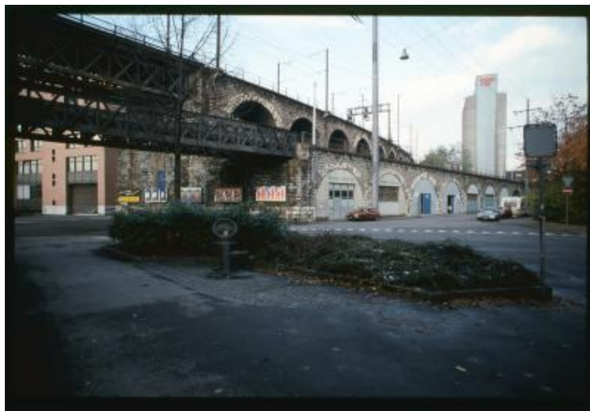
Zurigo. Ponte ferroviario nel distretto di Aussershil
