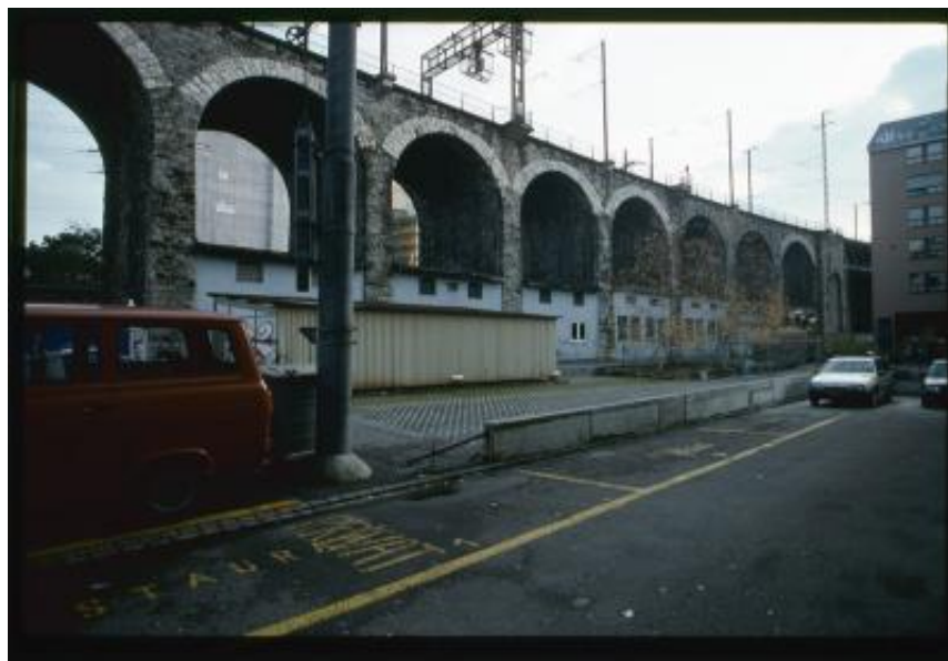
Zurigo. Ponte ferroviario in pietra nel distretto di Aussershil
