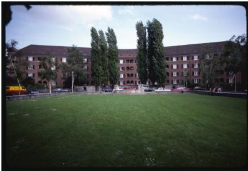
Zurigo. Veduta del complesso residenziale Städtische Siedlung Birkenhof
