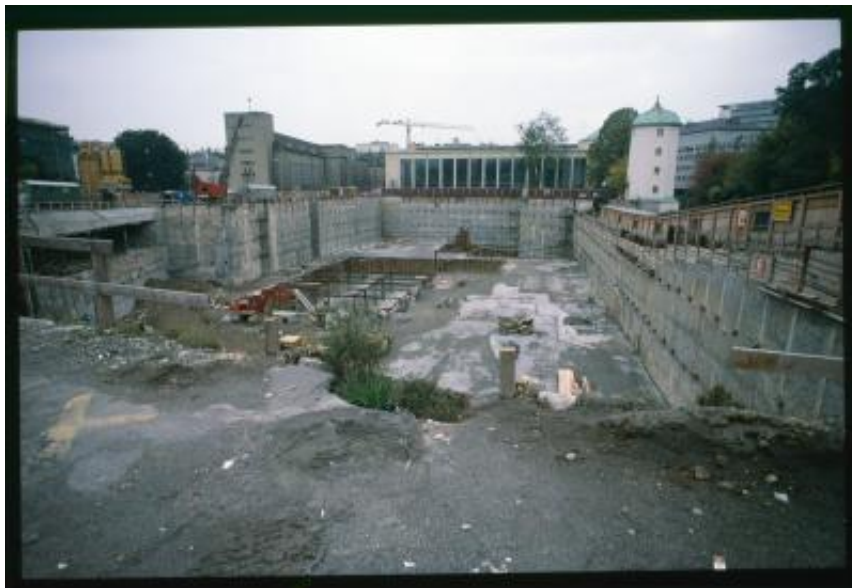
Zurigo. Veduta di un cantiere
