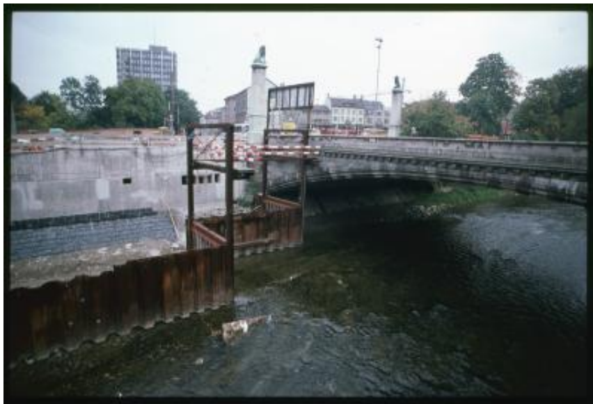
Zurigo. Lavori nei pressi della stazione Selnau e del fiume Sihl
