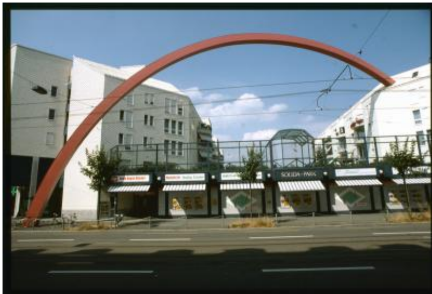
Zurigo. Arco all'ingresso di un centro commerciale sulla Badenerstrasse
