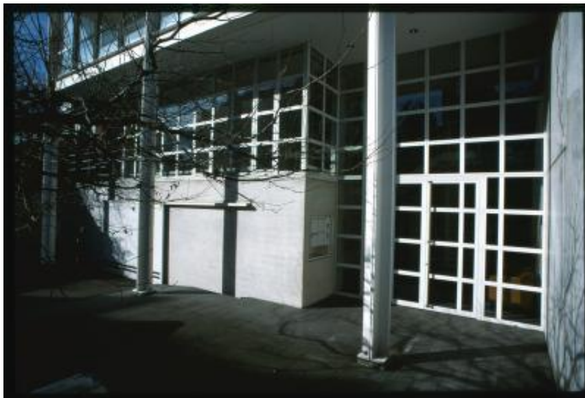
Zurigo. Wohnhaus am Zürichberg di Theo Hotz sulla Schneckenmannstrasse
