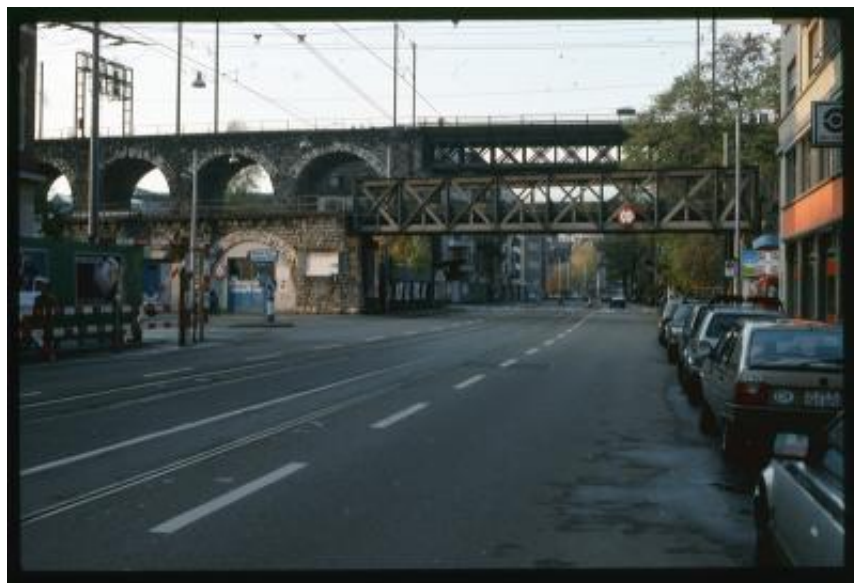
Zurigo. Veduta di un ponte ferroviario nel distretto di Aussershil
