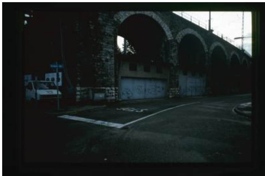
Zurigo. Archi di un ponte ferroviario nel distretto di Aussershil
