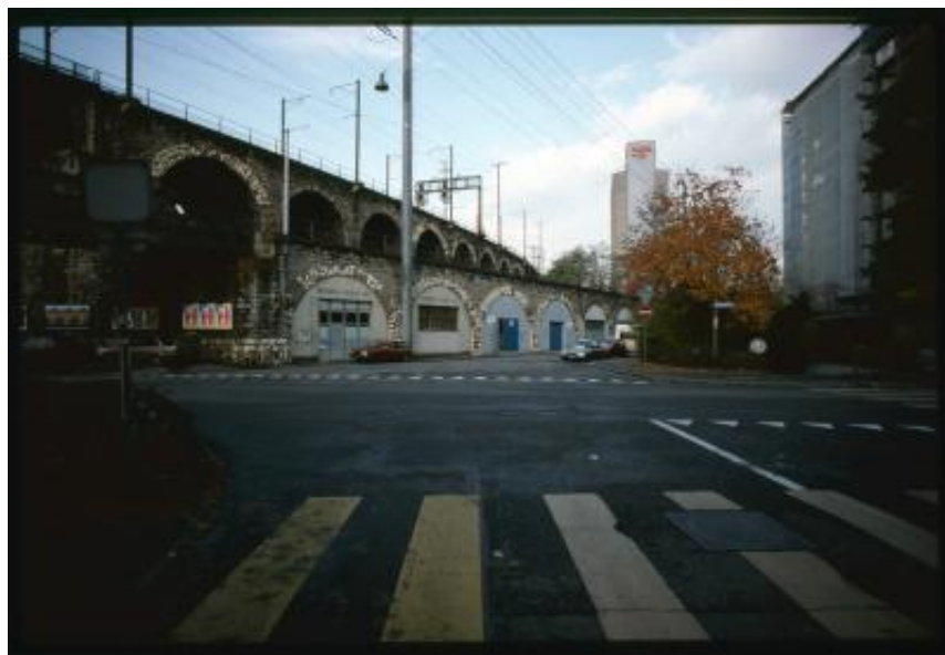
Zurigo. Veduta di un ponte ferroviario nel distretto di Aussershil
