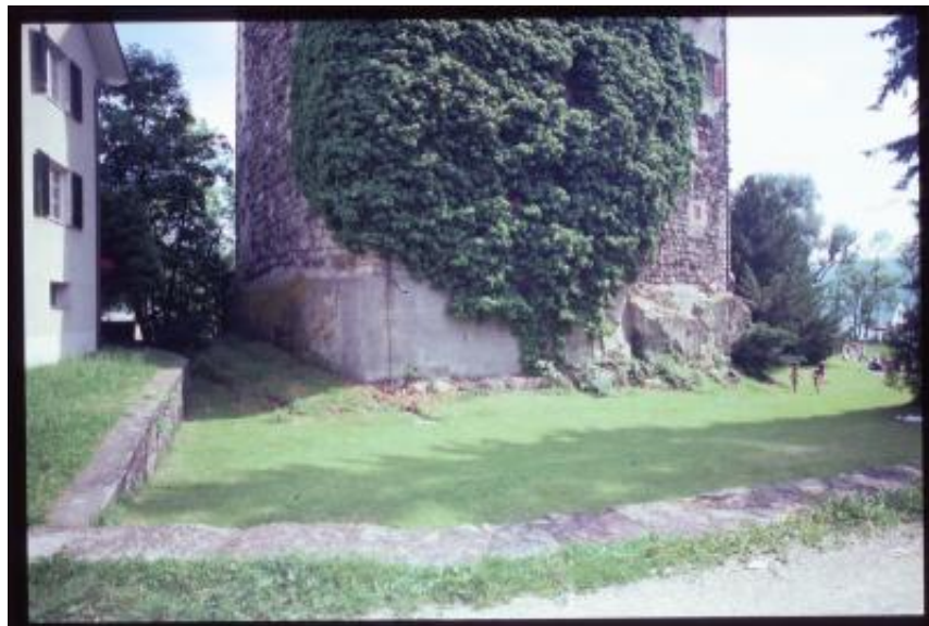
Greifensee. Dettaglio della facciata del castello
