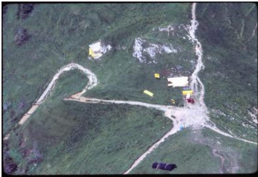
Hoher Kasten. Veduta aerea di un sentiero
