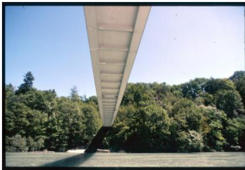
La Passerelle du Lignon a Vernier vista dal Rodano
