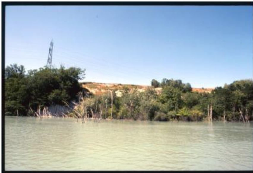
Veduta di una riva del Rodano nell'area della diga di Verbois
