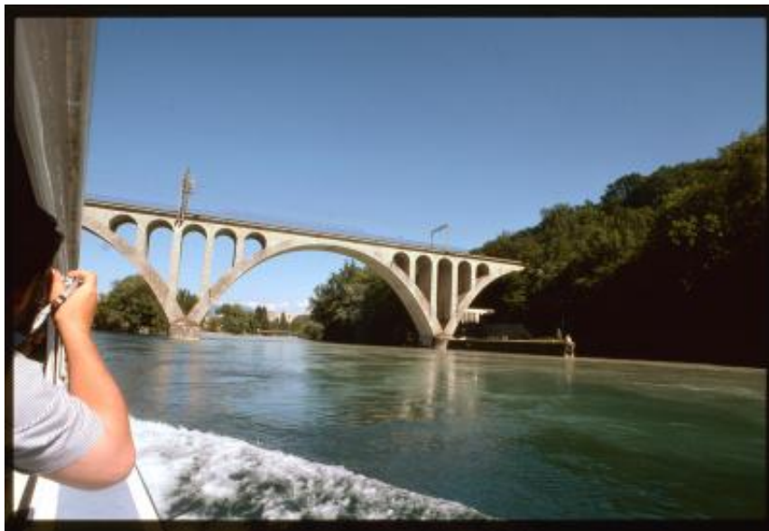
Veduta del Viaduc de la Jonction dal Rodano
