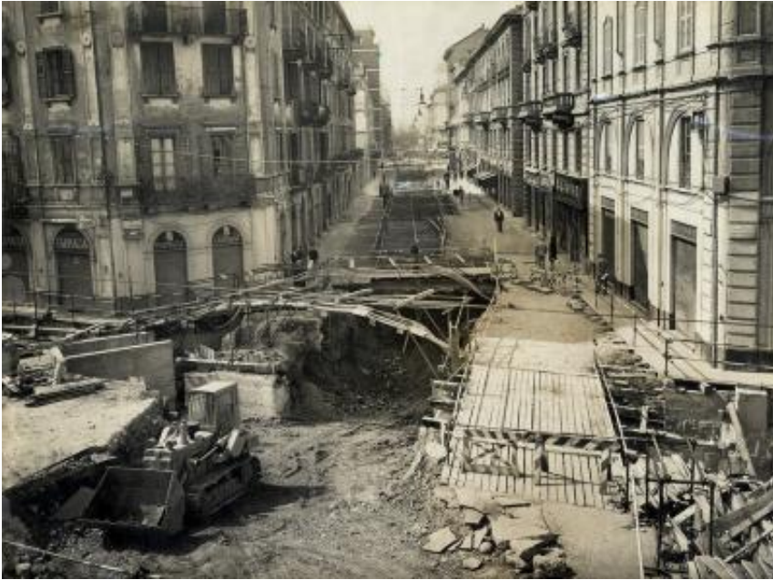
Scavo di sbancamento in piazza Wagner e, in secondo piano, le passerelle carrabili ai lati di via Marghera
