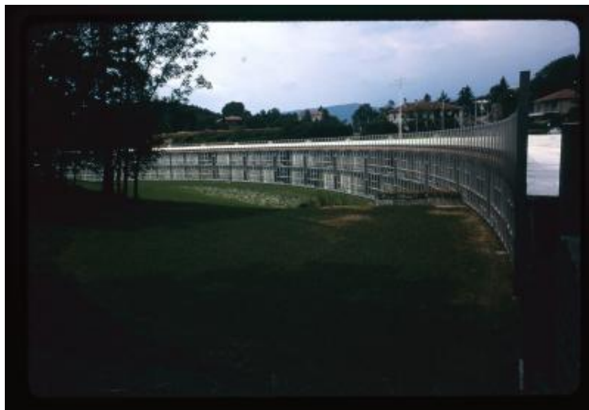
Ivrea. Facciata vetrata dell'unità residenziale Ovest Olivetti Talponia
